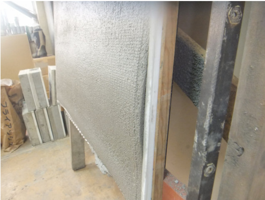
写真 1 2 たるみ状況 (測定部位⑨部)
